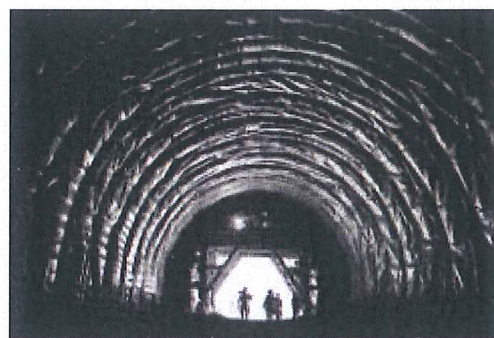
相机作品《致富通道》摄影爱好者田文国 2018.4通道县公路施工现场 1890745219.jpg
